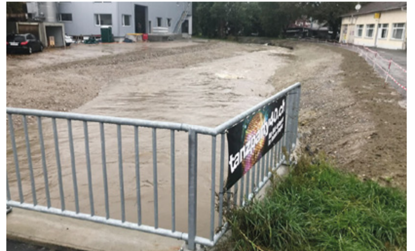
Schon kurz nach Bauabschluss hat der neu revitalisierte Abschnitt bei einem ersten Hochwasser seine Funktionsfähigkeit unter Beweis gestellt.
