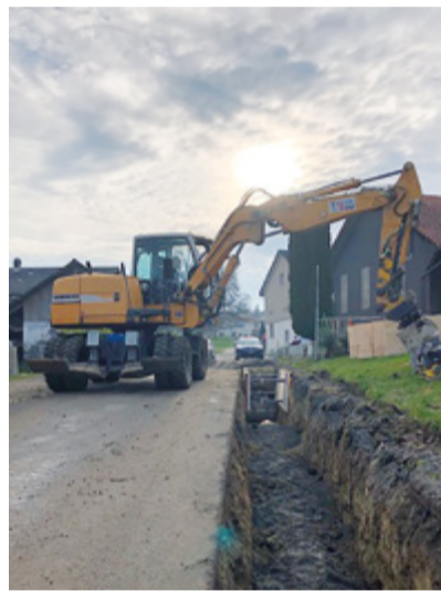
Die Arbeiten bezüglich Regenwasser Ableitung Holzmannshaus schreiten voran.
