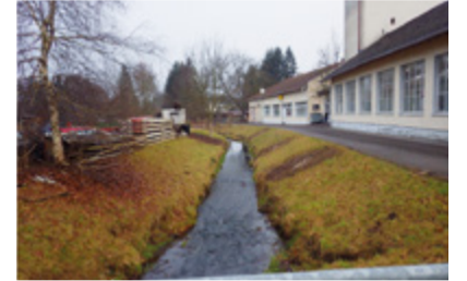
Ein monotones Gerinne, die seitlich angrenzenden Liegenschaften waren durch Hochwasser gefährdet.
