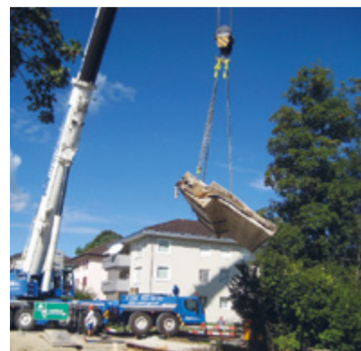
Kran mit Teilstück der Brücke
