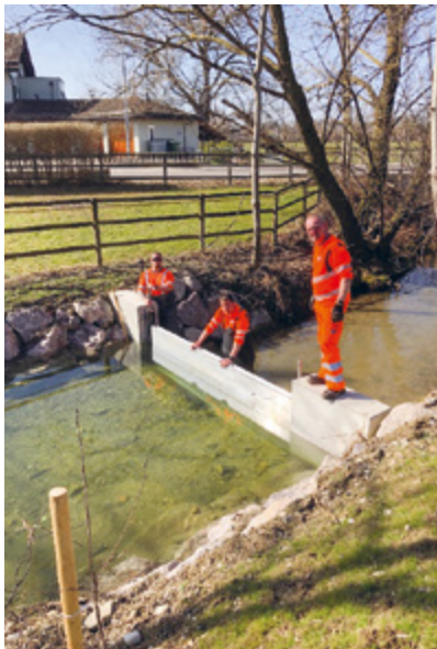
Schotten dicht – Test bestanden!
