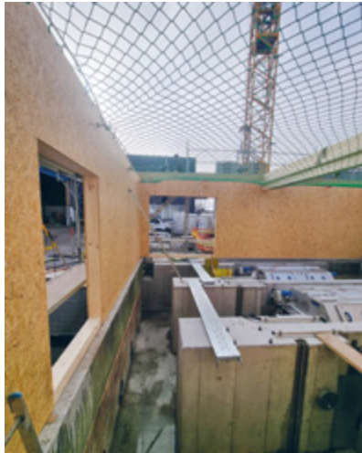
Einblick in den Rohbau der neuen Maschinenhalle.
