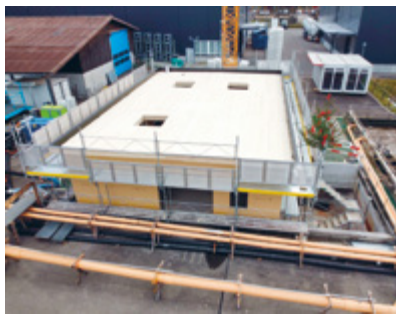
Rohbau der Maschinenhalle.
